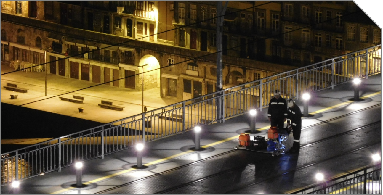
Inspeção de carril ferroviário no Metro do Porto
